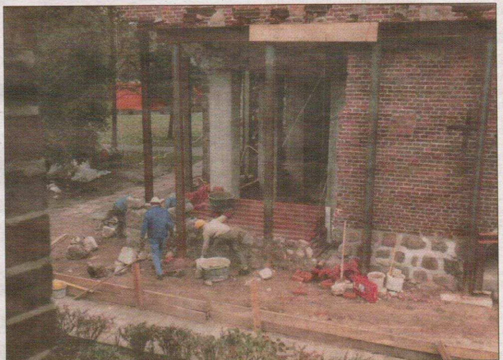
Provisorisches Abstützen des Turmes durch Stahlträger.
