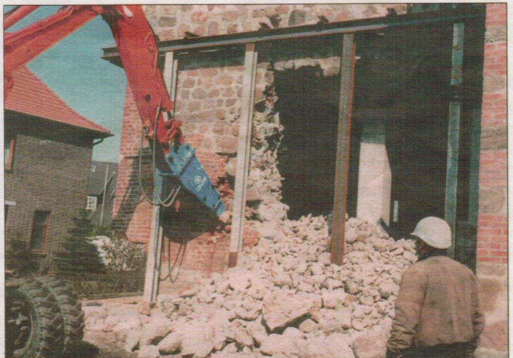
Schweres Gerät half beim Abbruch.
